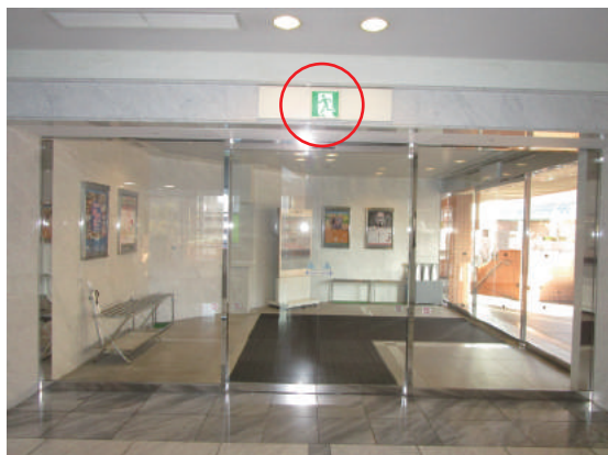
(a) 自動扉非常口
