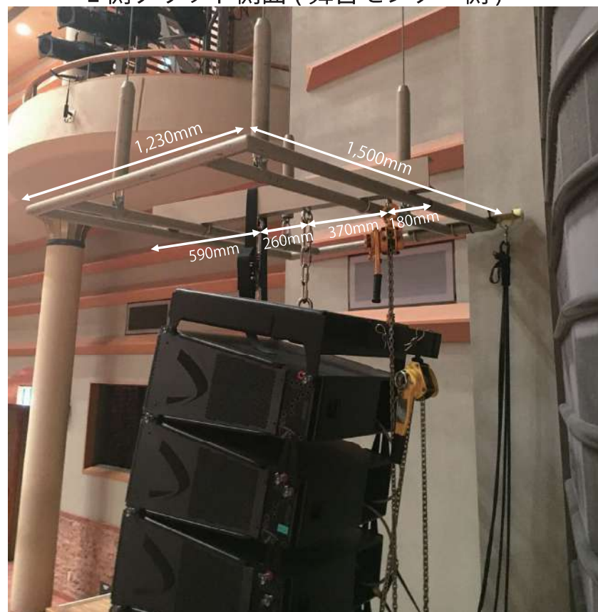
L側グリッド側面 (舞台センター側)
